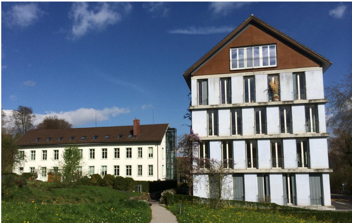
Fabrikgebäude GRÜFA und Wohnhaus Mülener
